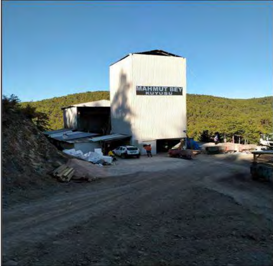
Foto 4: Mahmut Bey Kuyusu Yeraltı İşletmesi Girişi
