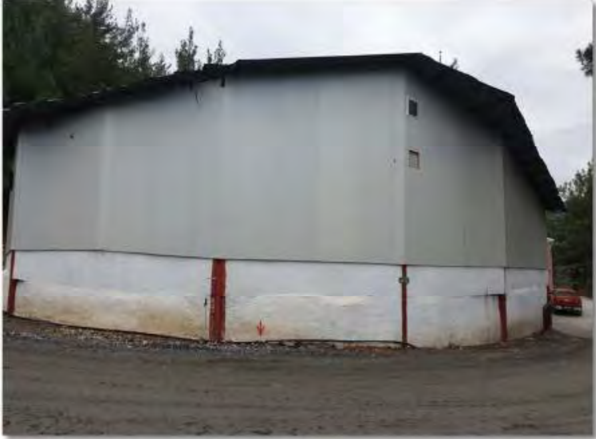
Foto 10: Örneklenen Karot Numunelerinin Saklandığı Depo
